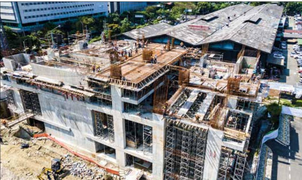
Figura 5 – Edifício em execução na Colômbia com uso de LC3.
